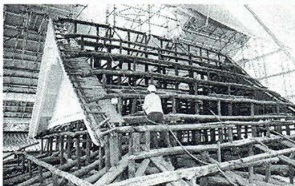
大屋根修理の現場です
